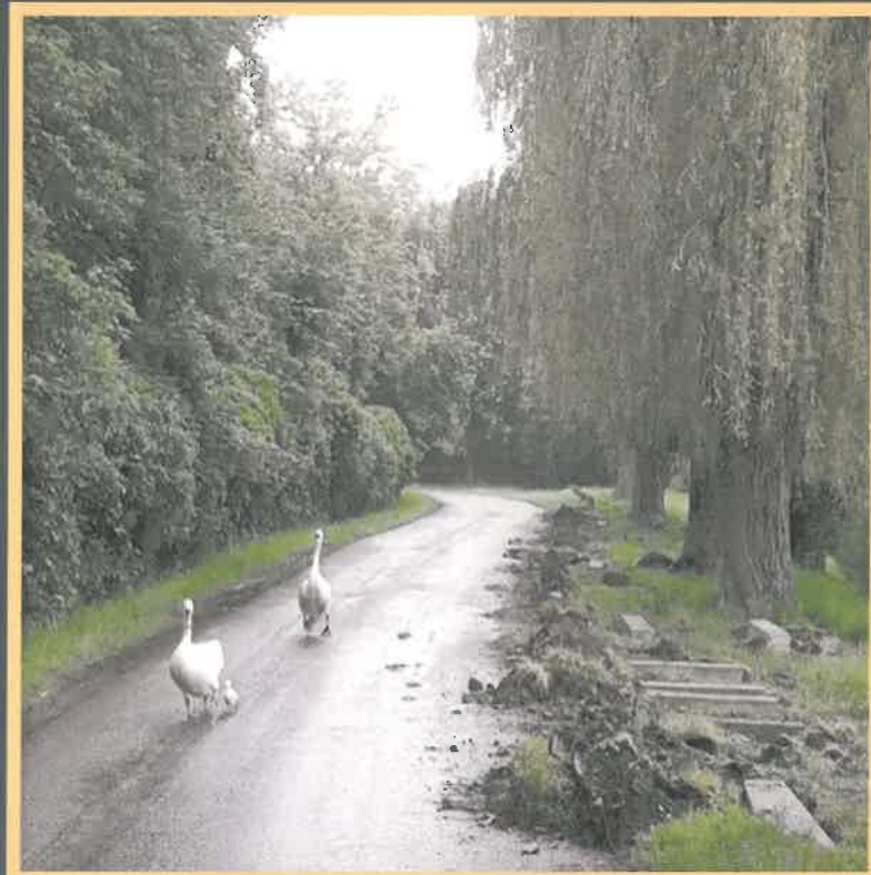
Les travaux du bord de La Lanterne sont bien surveillés !
